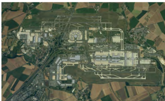
A. Vue aérienne de l’aéroport CDG
