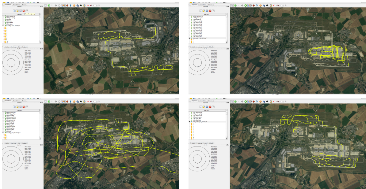
FIGURE 6.2 – Les quatre différentes trajectoires empruntées par le récepteur pour construire le dataset Aéroport Charles-De-Gaulle.
