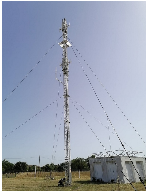
FIGURE 2.3 – Pylône d'essai mis à disposition situé sur le site de la DTI
